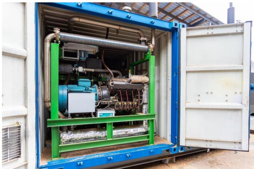
В данной конфигурации используются 2 морских 40 фут контейнера в которых устанавливаются 4 отдельных реактора, 4 системы фильтрации и 4 газ генератора. Генераторы американского производства.
